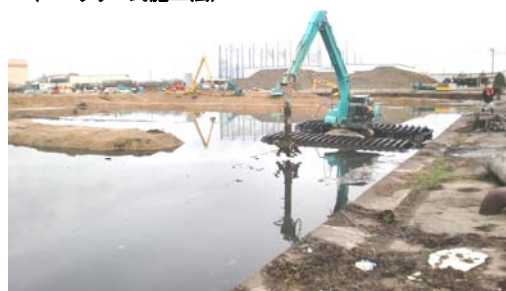
RM工法 (ロータリー式施工法)
