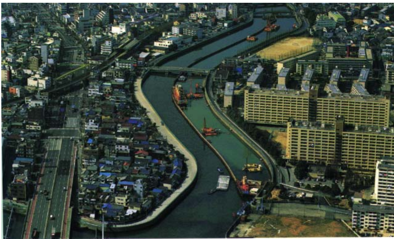
FAM工法(長尺横行式水中施工法)：阪神高速淀川左岸線正蓮寺工区
