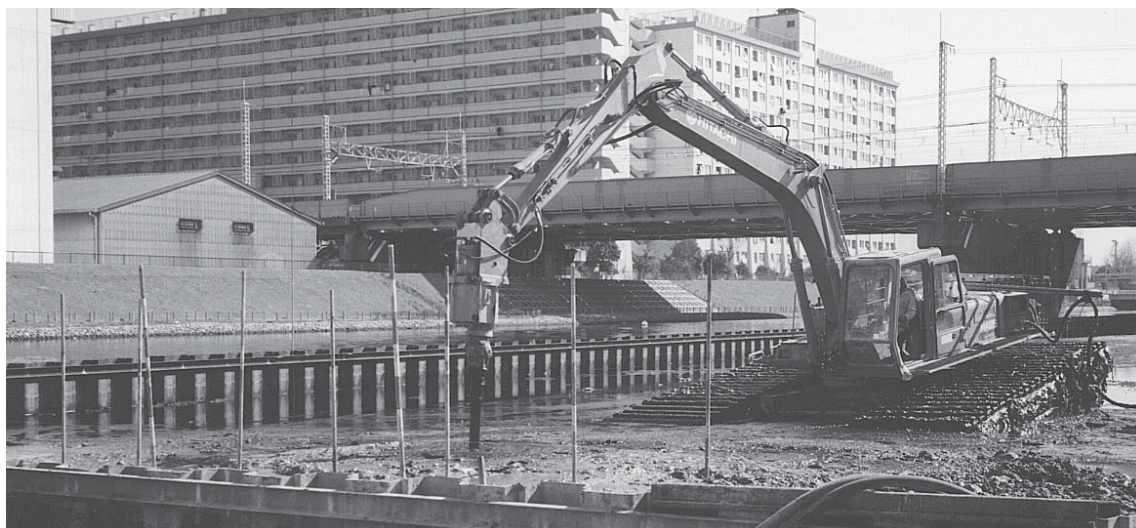
図5-17 VM工法の施工位置セット模式図
