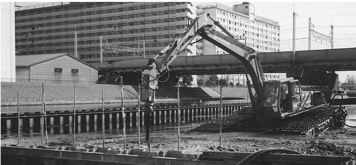
図5-17 VM工法の施工位置セット模式図
