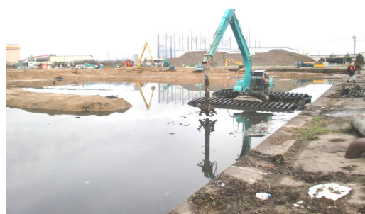
R M工法（ロータリー式施工法）
