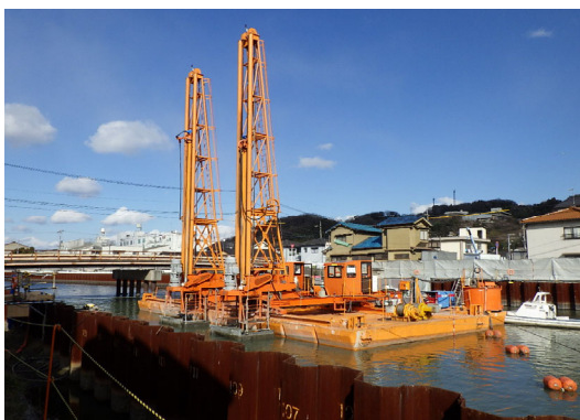
F A M工法（長尺・横行式水中施工法）
