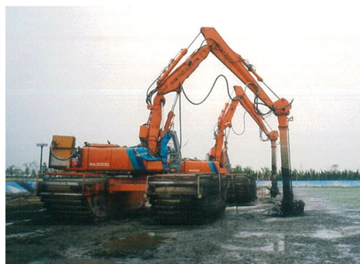
A R M工法（自動ロータリー式施工法）
