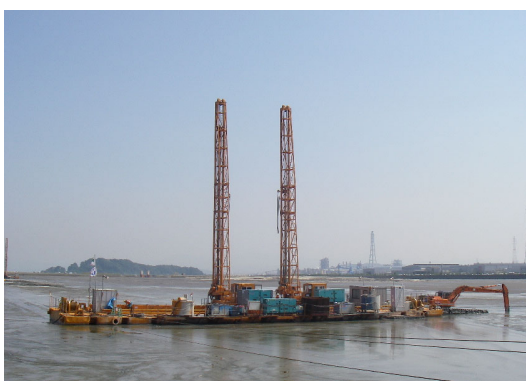
F V M工法（長尺・横行式泥上施工法）
