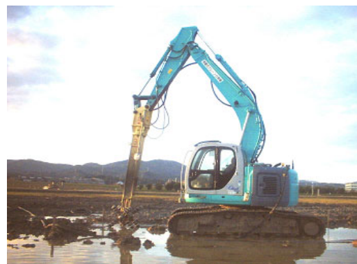
B H - R M工法（バックホウタイプロータリー式施工法）
