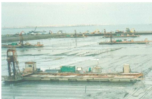
F S M工法（横行連続式施工法）
