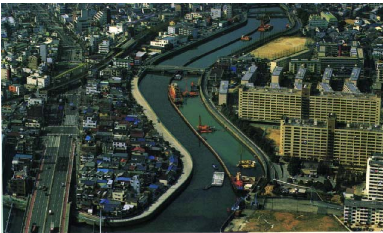
FAM工法(長尺横式水中施工法)：阪神高速淀川左岸線正蓮寺工区
