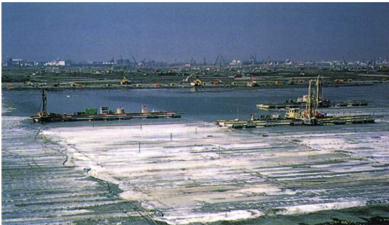
FSM工法(横行連続式施工法)：羽田沖処理場拡張部表層固化工事
