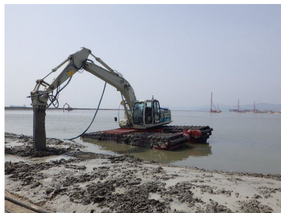
施工状況写真（例3）
