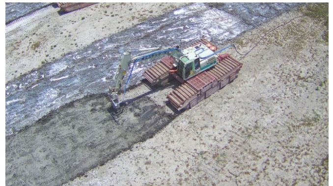
施工状況写真（例2）
