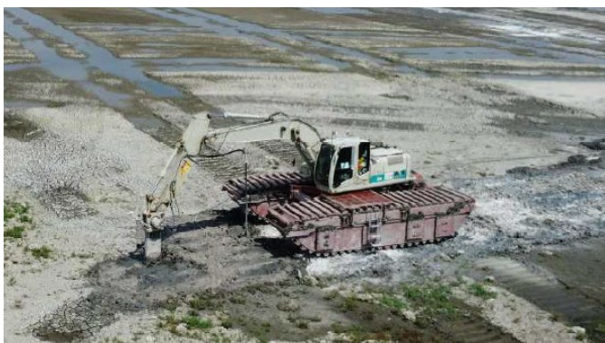
施工状況写真（例1）
